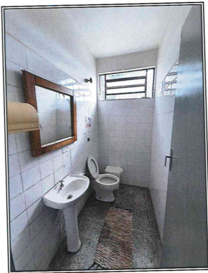
ASPECTOS DO PRÉDIO 1
