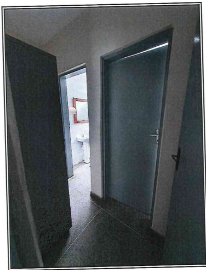
ASPECTOS DO PRÉDIO 1
